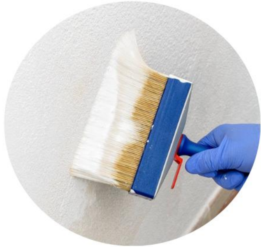
粉刷墙壁的石灰浆
